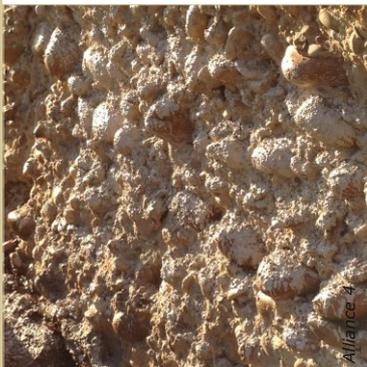
Le gobetis est un mortier assez fluide, richement dosé en chaux, projeté fermement à la truelle. Ici, un ancien soubassement en béton de chaux reçoit le gobetis, après avoir été purgé.
