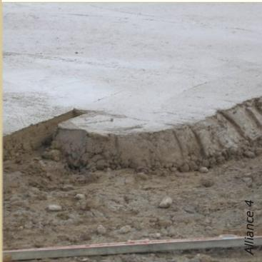
Le béton de chaux a une consistance ferme, jamais coulant pour éviter le retrait.
