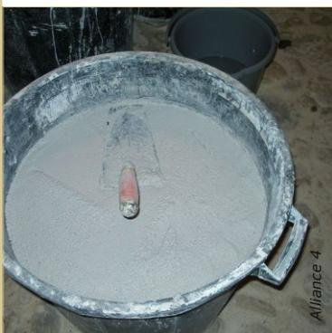
Les mortiers à la chaux aérienne doivent être préparés au moins la veille de leur mise en œuvre. Stockés dans des contenants et recouverts d'un voile d'eau, ils se conservent plusieurs mois.
