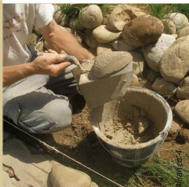
Mortier de chaux NHL2 et de sable 0/4 pour la réalisation d'un mur en galets.
