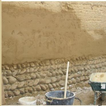
Un corps d'enduit à l'argile fibré est appliqué sur une façade en pisé.
