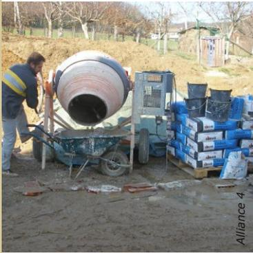
La bétonnière est un outil adapté au brassage des mortiers lourds. Le volume de malaxage des grosses bétonnières permet de mélanger un sac de liant à la fois.
