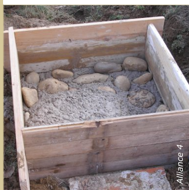
Ce socle 70 x 70 cm servira de base à l'édification d'un pilier en briques pour une construction en poteau-poutre.
