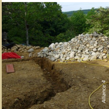
Le chantier est prêt : le terrassement est réalisé et les pierres sont livrées.
