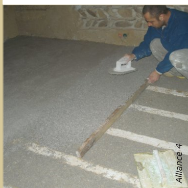
Une lambourde volante sert au repérage de l'épaisseur de la 2ème passe en cours de tassage.
