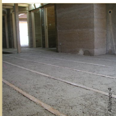
Des lambourdes noyées dans la masse apparaissent à fleur de la dalle. Le parquet sera cloué sur des contre-lattes.
