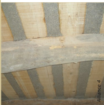
Vue d'un plancher à la provençale après décoffrage. Le béton de chaux et chanvre est particulièrement adapté aux structures bois.
