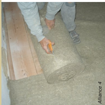
Le feutre de chanvre permet de désolidariser la dalle du plancher.
