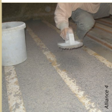
La première couche de béton de chanvre est mise en place entre les solives, sur une sous-face en lattes enduit.
