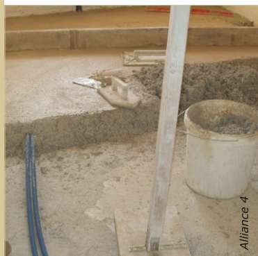
Deux nus de niveaux sont mis en place le long des murs. La partie centrale est remplie en reculant. Une fine couche d'enduit chaux/sable est appliqué au fur et à mesure du coulage de la dalle.
