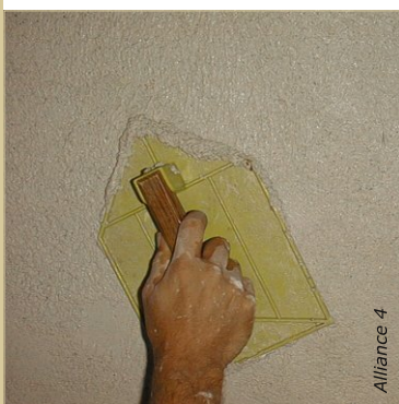
Taloche le corps d'enduit dès qu'il commence à être ferme : les mouvements circulaires bien appuyés déplacent la matière, aplatissent les bosses et comblent les creux.
