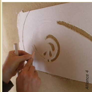
Les enduits fins peuvent être gravés ou découpés. Cette technique s'appelle sgraffito.
