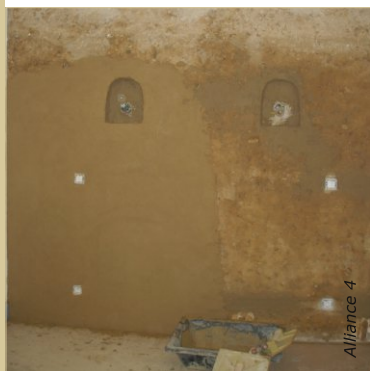
Corps d'enduit à l'argile sur pisé en cours d'application. Le gobetis est inutile terre sur terre si le support est brossé généreusement à l'eau.
