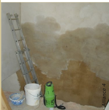
Les étapes pour l'application d'un enduit à la chaux sur mur en pisé : humidifier au pulvérisateur, appliquer un badigeon de chaux, projeter un gobetis puis appliquer le corps d'enduit à la chaux.
