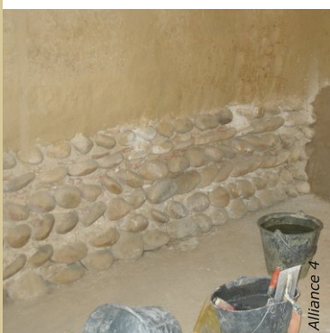
Préparation du mur : les parties friables ont été grattées puis soufflées à l'air comprimé.
