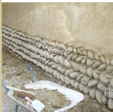
Reconstruction du soubassement à l'identique (galets roulés) et rebouchage des érosions et fissures dans le pisé avec du béton d'argile.
