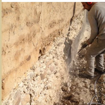
L'enduit au ciment sur le soubassement est retiré au marteau piqueur.
