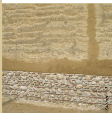
Le parement extérieur du soubassement a dû être reconstruit.
