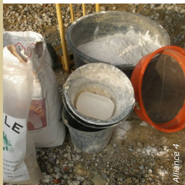
En finition, tous les sables ou poudres de marbre doivent être tamisés pour retirer les éventuelles impuretés.
