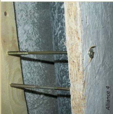
Dans une des technique de coffrage : la vis de butée détermine l'épaisseur du doublage. La vis de serrage maintient le coffrage.
