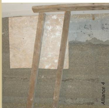
Le haut du doublage se fait avec un coffrage mobile et remplissage latéral lorsque l'accès par dessus est impossible.
