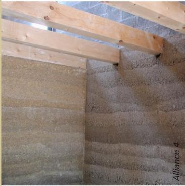
Le béton de chanvre est un matériau clé des habitations bio-compatibles. Il peut être utilisé à de multiples postes (dalles, toitures, doublages, murs, cloisons).
