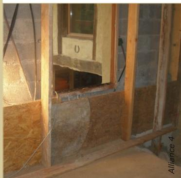
Le coffrage est ici maintenu par une structure extérieure, fixée au sol et aux solives du plafond. Il s'agit de la lisse haute et basse.
