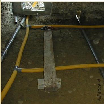
Avant la pose du hériçson de pierres, le sol est nivelé avec une légère pente. Les drains d'eau et drains d'air sont ensuite mis en place.
