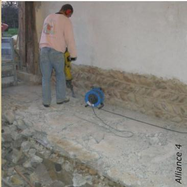
Démontage d'une dalle en béton de ciment ayant entraîné des désordres humides marquants.
