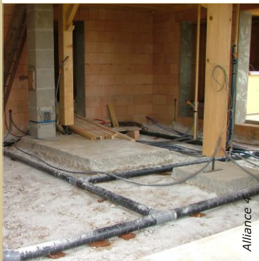
Les socles pour la pose d'éléments porteurs (poêle de masse, départ d'escalier, piliers, murs de masse), en béton cyclopéen, sont coulés avant la pose de la dalle chaux et chanvre.
