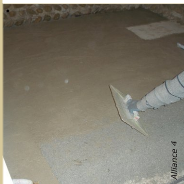
Le béton de chanvre est tassé à la dame puis enduite, à frais, avec un mortier de chaux aérienne, taloché pour niveler la surface.
