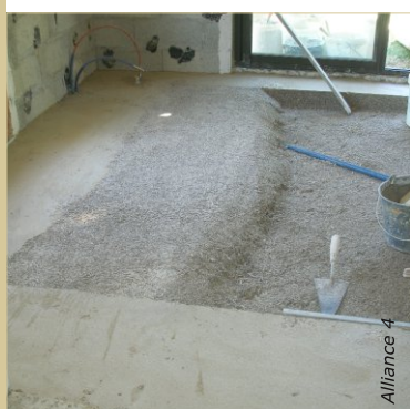
Une fine couche d'enduit à la chaux peut être appliquée sur la 2 ème couche de béton de chanvre. Elle forme une croûte plus dure qui évite l'abrasion du béton de chanvre durant le chantier.
