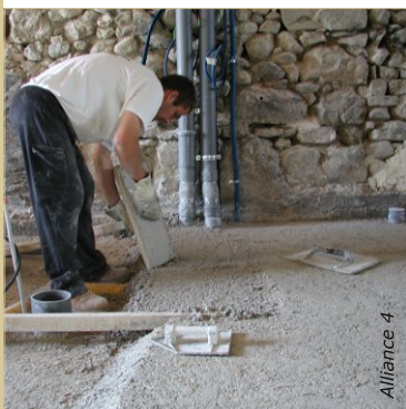
Le béton de chanvre est posé directement sur le hérisson de pierre ventilé. Ce dernier est obligatoire sous ce type de dalle.
