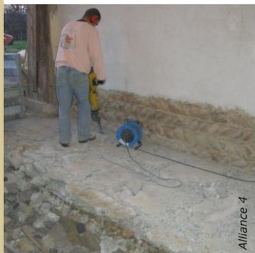
Démontage d'une dalle en béton de ciment pour résoudre des désordres d'humidité marquants.
