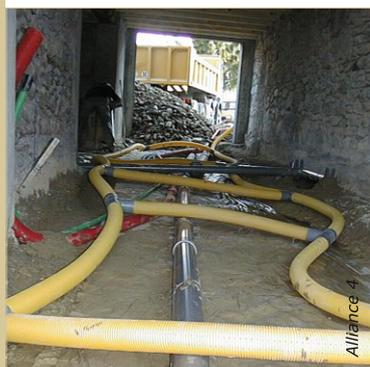
Avant la pose du hêrisson de pierres, mettre en place les arrivées d'eau, l'évacuation des eaux usées, les arrivées électriques, etc. Placer ensuite les drains d'air du hêrisson.
