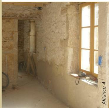
Les préparations pour ce support ancien en pierre sont : consolidation du soubassement avec un mortier de chaux NHL2, gobetis sur la partie haute et scellement des boîtes au mortier de chaux/plâtre.
