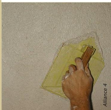
Le talochage est un mouvement circulaire bien appuyé. Il permet de donner la plânerie en égalisant les creux et bosses.
